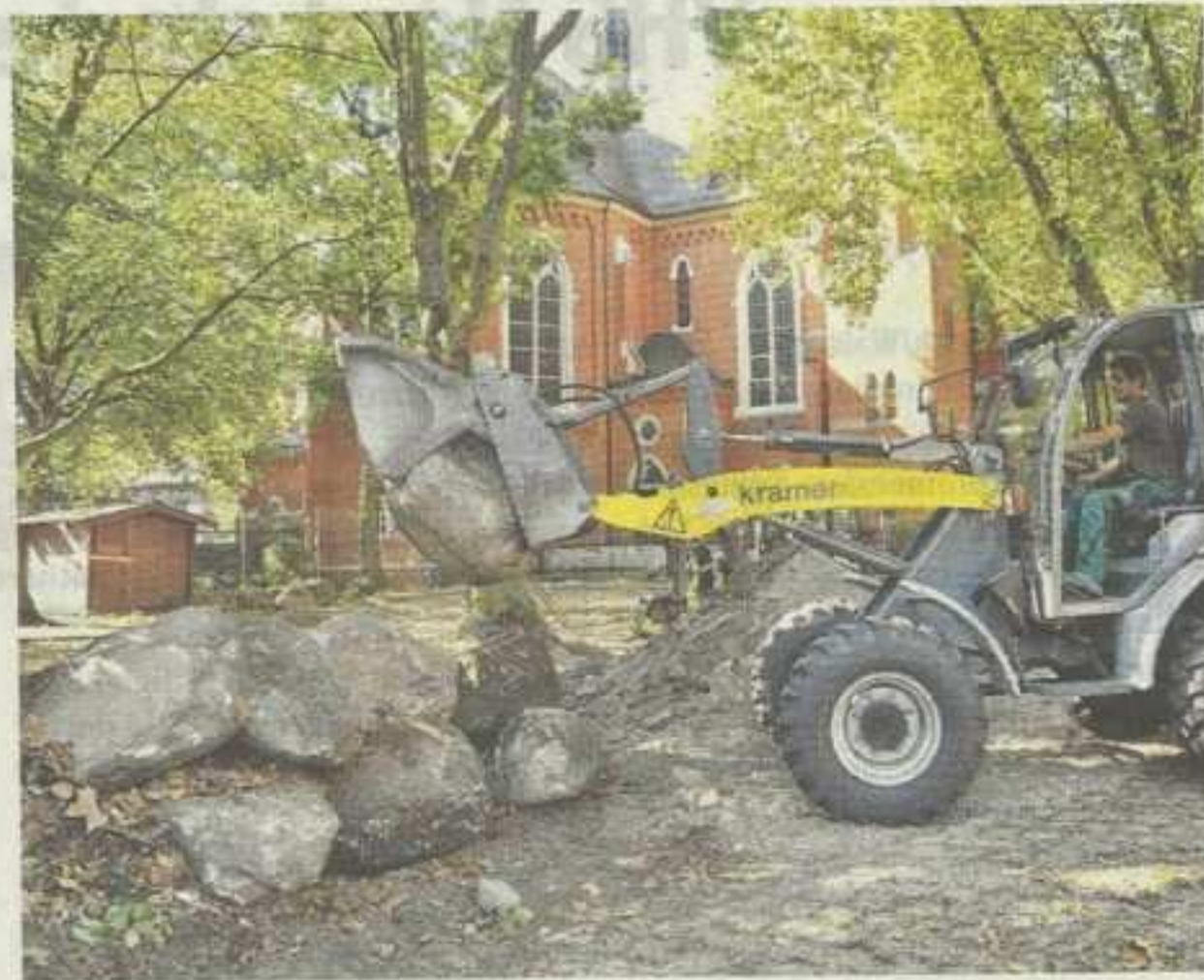
Auch die Findlinge müssen abtransportiert werden. Ende dieser Woche soll der Rückbau des Spielplatzes abgeschlossen sein.
