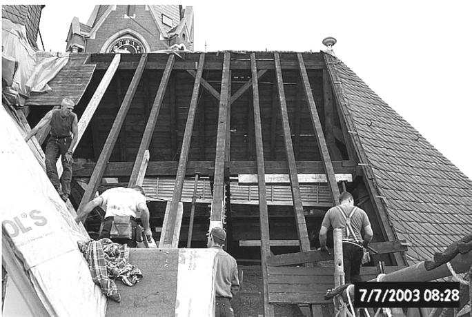
Ausbesserung und Erneuerung der Schalung unter dem alldeutsch gedeckten Moselschieferdach
